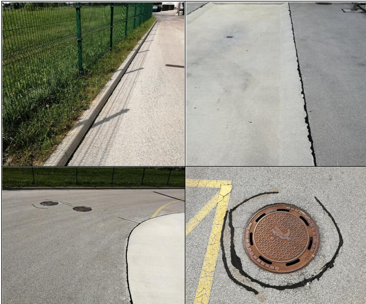
Slika 46: Primeri sanacije zunanjih utrjenih manipulativnih površin z zalivanjem s trajno-elastično polimerno bitumensko zalivno maso [34]
