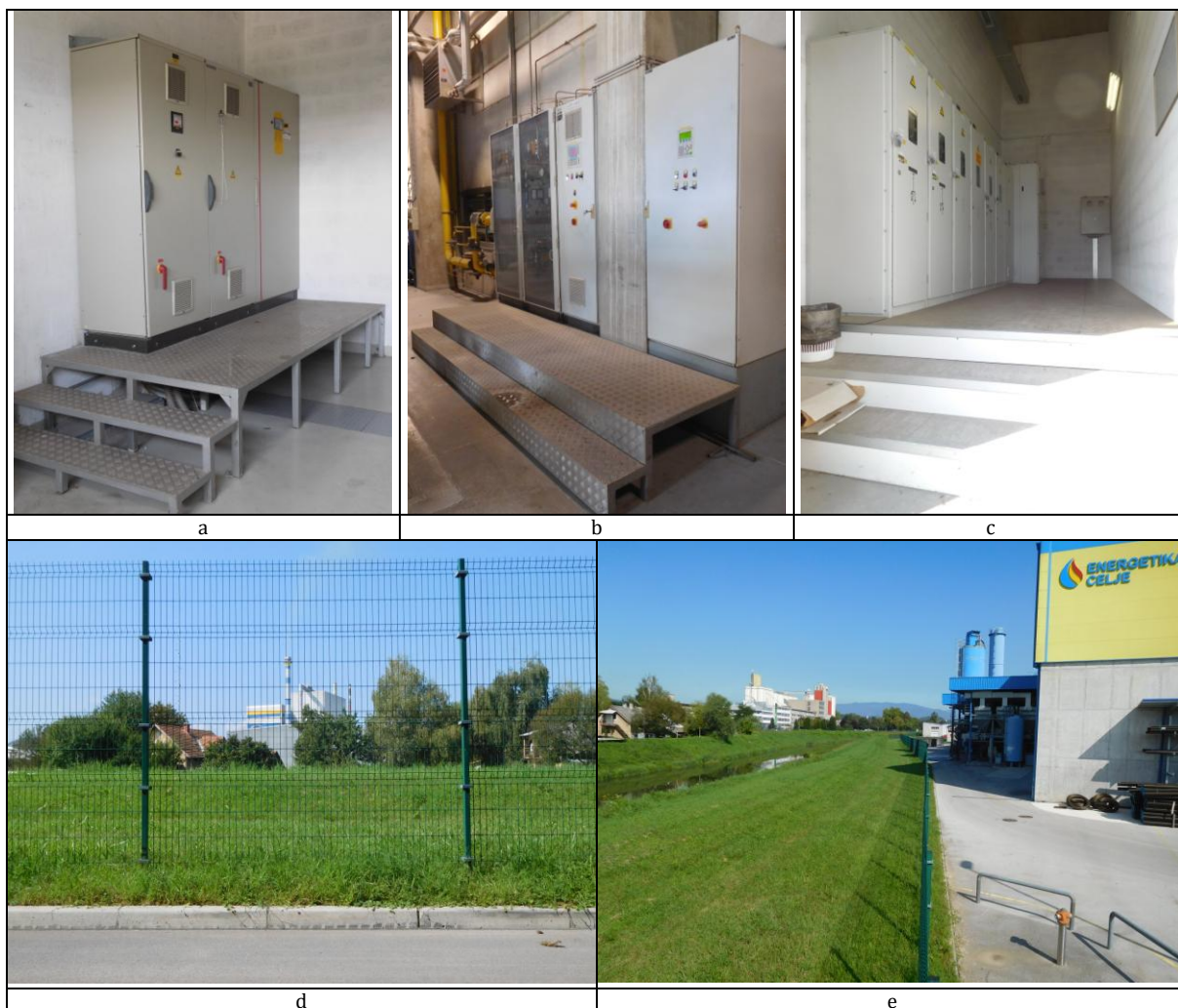
Slika 29: Izvedeni protipoplavni ukrepi na lokaciji Toplarne Celje; dvig vitalne tehnične opreme od tal (slika a,b,c) in izgradnja protipoplavnega nasipa na levem bregu Hudinje (slika d in e) [vir: Toplarna Celje]
