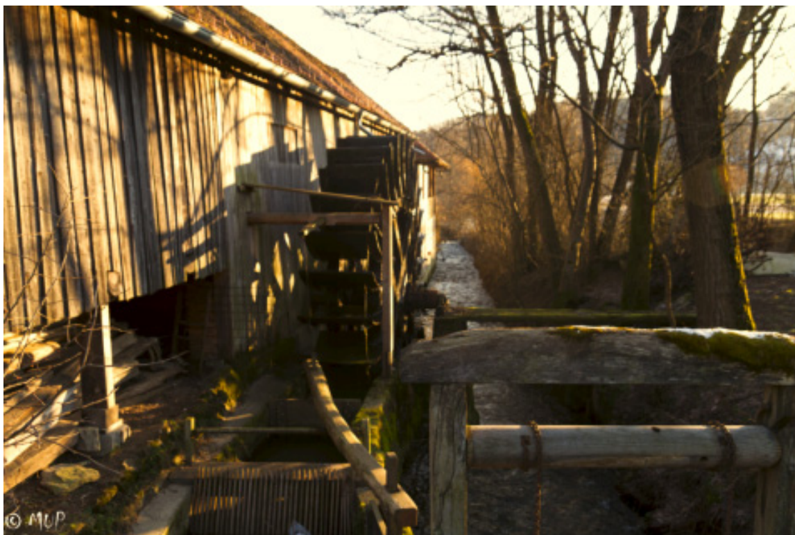
Slika 2. Vodni mlin v dolini Hudinje, januar 2011 (Foto: M. U. Pavlič) Figure 2. Water mill in Hudinja valley, January 2011 (Photo: M. U. Pavlič)
