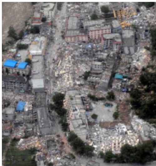
Slika 5. Nekatera mesta so bila skoraj v celoti porušena, saj je bila gradnja zelo slaba. Najbolj preseneča dejstvo, da so bili tudi družbeno pomembni objekti (šole, univerze, ...) zelo slabo grajeni
