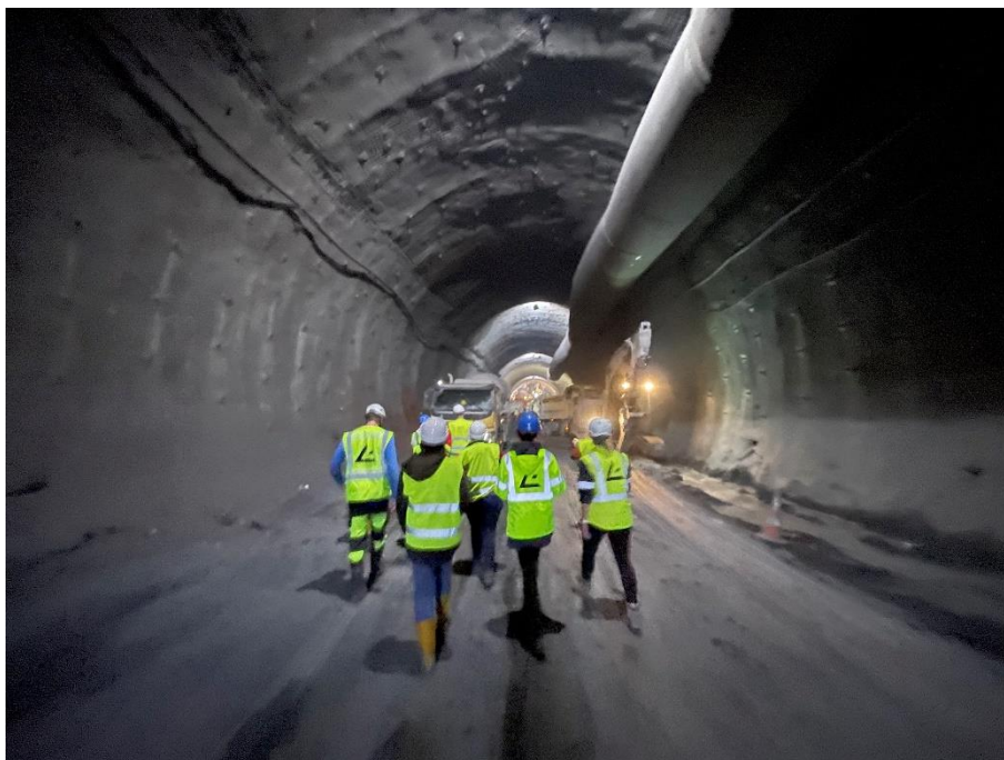
Slika 2. Izvedba vzhodne cevi cestnega predora Karavanke, ki izmed ostalih geoloških plasti prečka tudi obsežen dolomitni vodonosnik; oktober 2022 (Foto: U. Pavlič)
