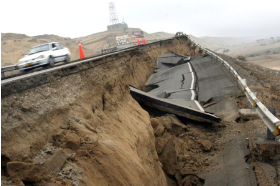
Slika 1. Delna porušitev cestišča na obalni cesti Panamerikana v okolici nadžarišča Figure 1. Partial collapse of roadway on the coastal road Panamericana in the surrounding of epicentre
