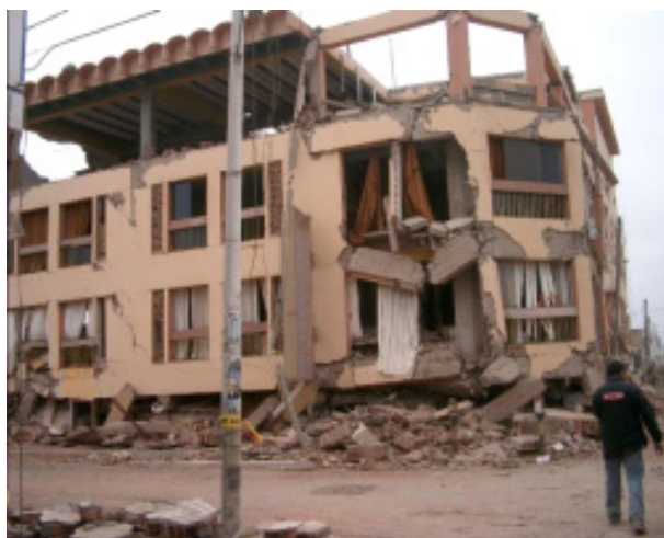
Slika 5. Armirano betonska konstrukcija Hotela Embassy v kraju Pisco se je porušila zaradi krhkega loma stebrov v pritličju
