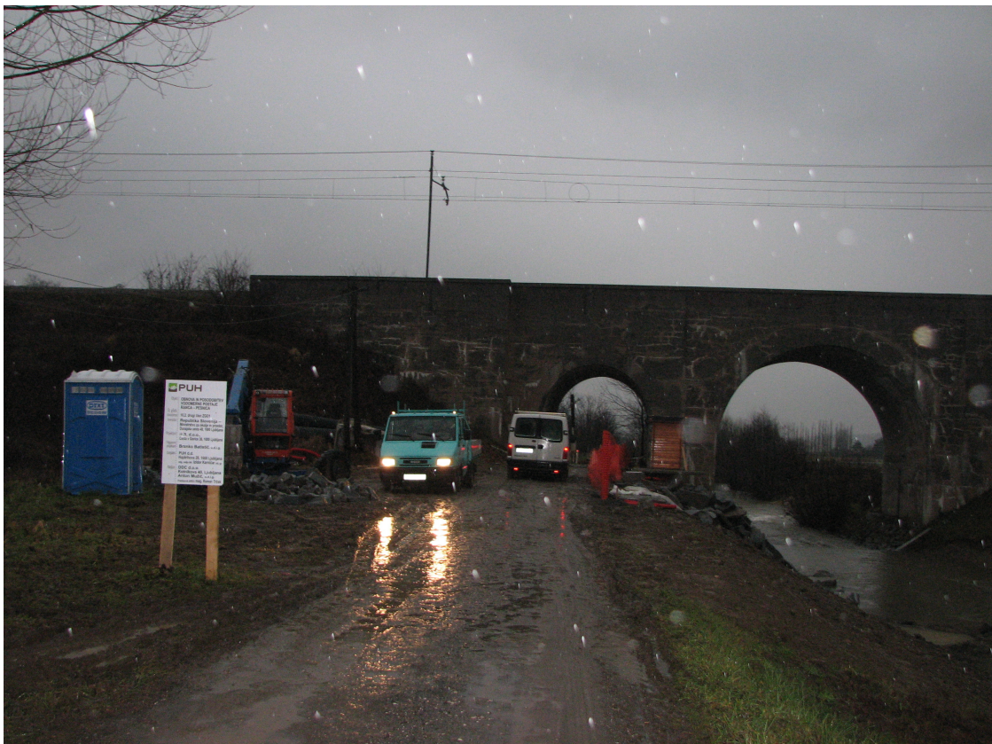
Slika 1: Izvedba gradbenih del na v.p. Ranca in v.p. Železniki je bila kljub izrazito neugodnim vremenskim razmeram izvedena zelo kvalitetno in z minimalnim časovnim zamikom (foto: Primož Gajser)
