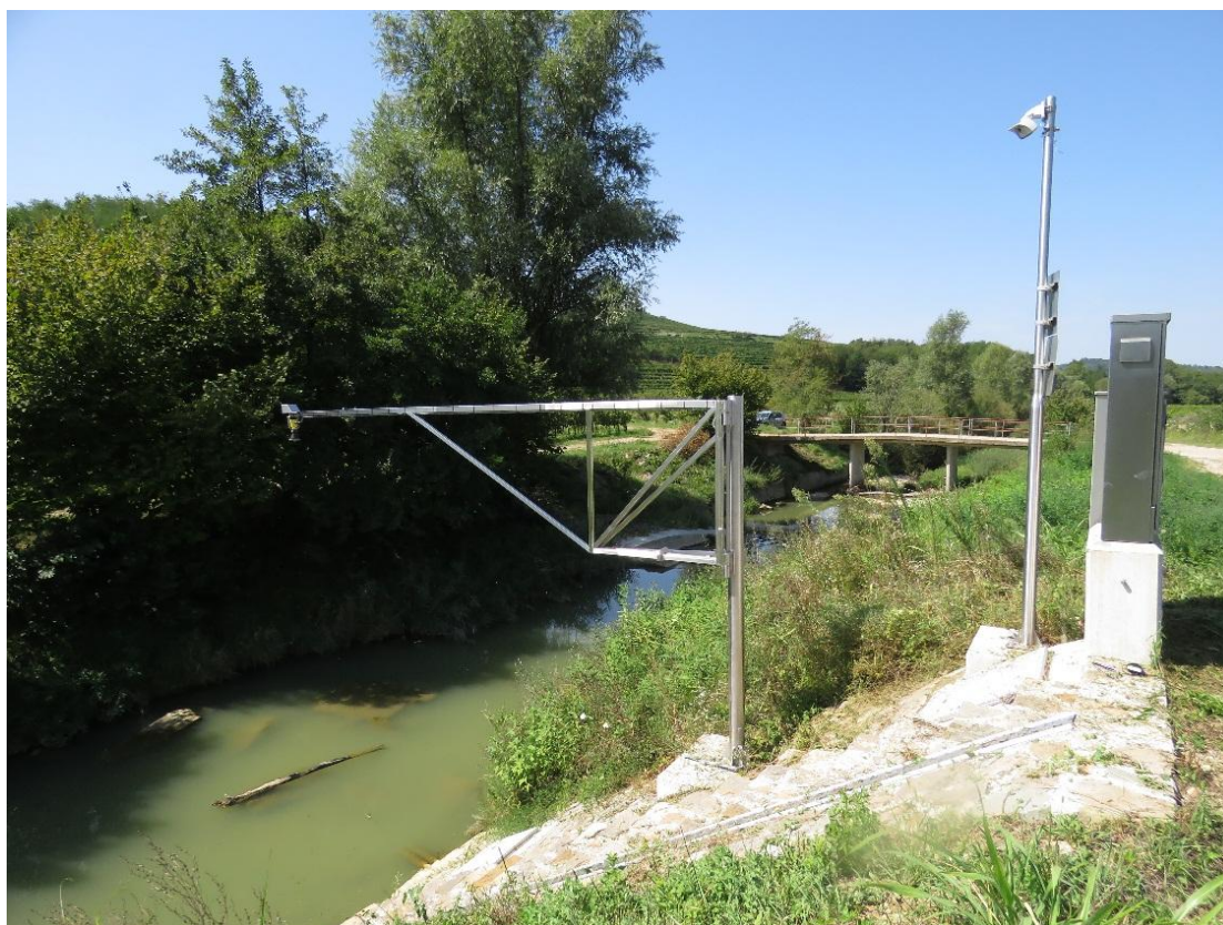
Slika 4: Prenovljeno merilno mesto Neblo na Reki (foto: arhiv ARSO)
