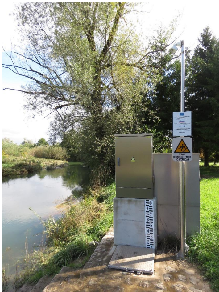
Slika 5: Prenovljeno merilno mesto Ig na Ižici (foto: arhiv ARSO)
