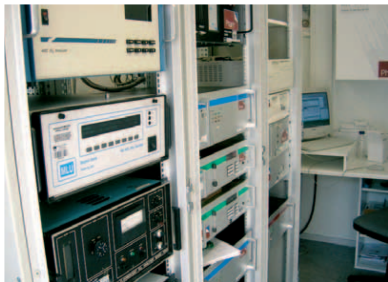
Notranjost avtomatske merilne postaje (foto: Peter Pavli)
